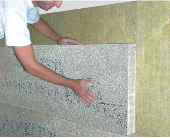
Errichtung der Vorsatzschale
