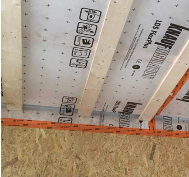
Untergrund für die Plattenbefestigung: Wand mit OSB-Platte und Decke mit Streuschalung (e= 50 cm)
