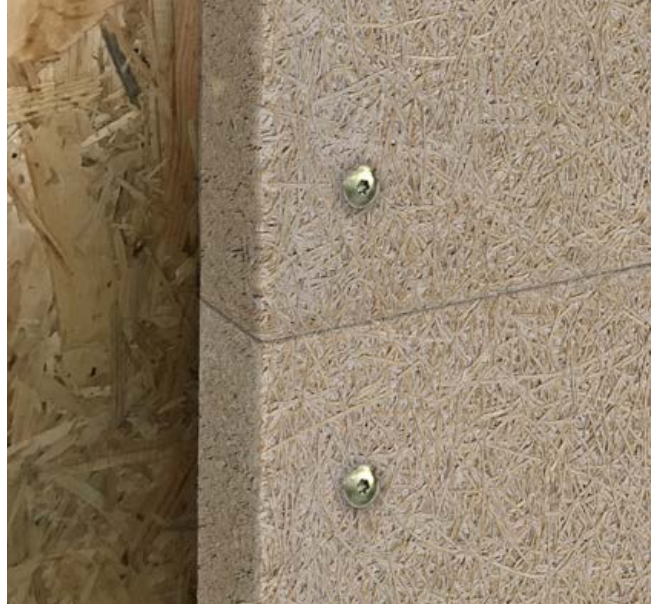
Beplankung Wand: Heraklith BM Platten 50 mm, befestigt mit Heraklith Kompaktbauschrauben (Länge 80 mm) auf OSB-Platten.
