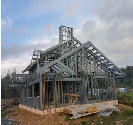
Рисунок 7 – Вариант конструктивного исполнения здания с несущим стальным каркасом из тонколистовых оцинкованных холодногнутых профилей
