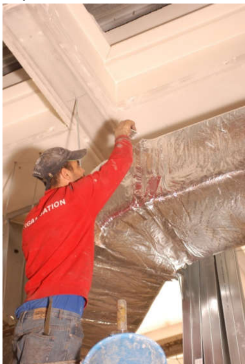
Рисунок 6.12. Изоляция воздуховодов приточной вентиляции прямоугольного сечения.
