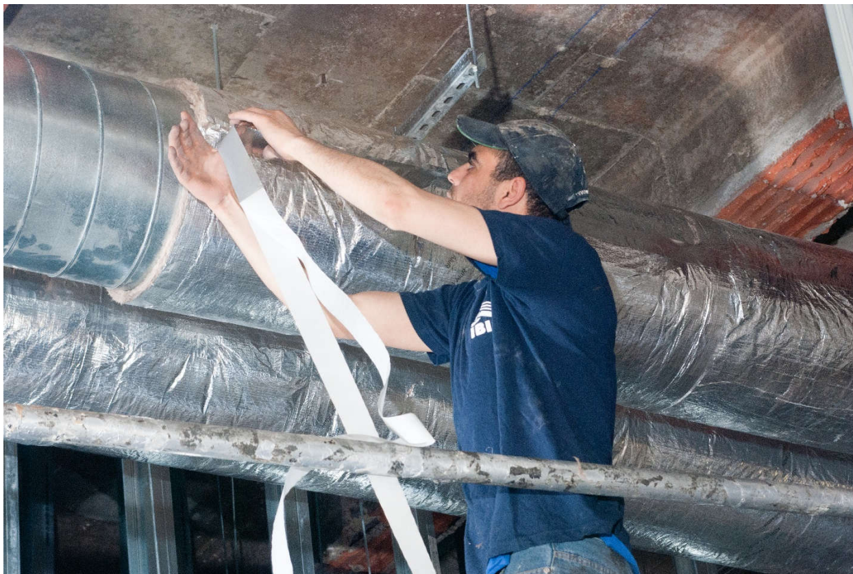
Рисунок 6.4. Герметизация продольного шва изолируемой конструкции алюминиевой клейкой лентой
