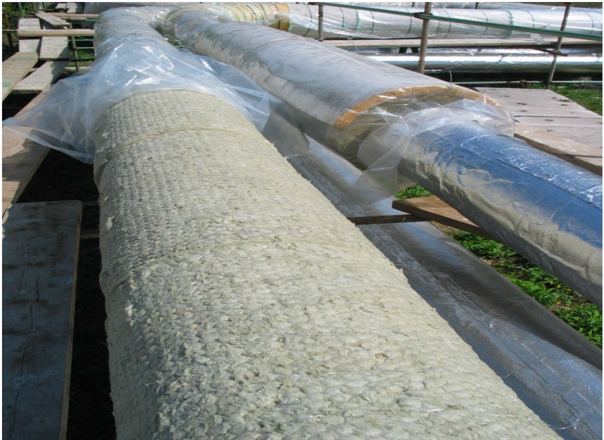
Рисунок 6.7. Защита теплоизоляционного материала от увлажнения дождем при монтаже тепловой изоляции на трубопроводе
