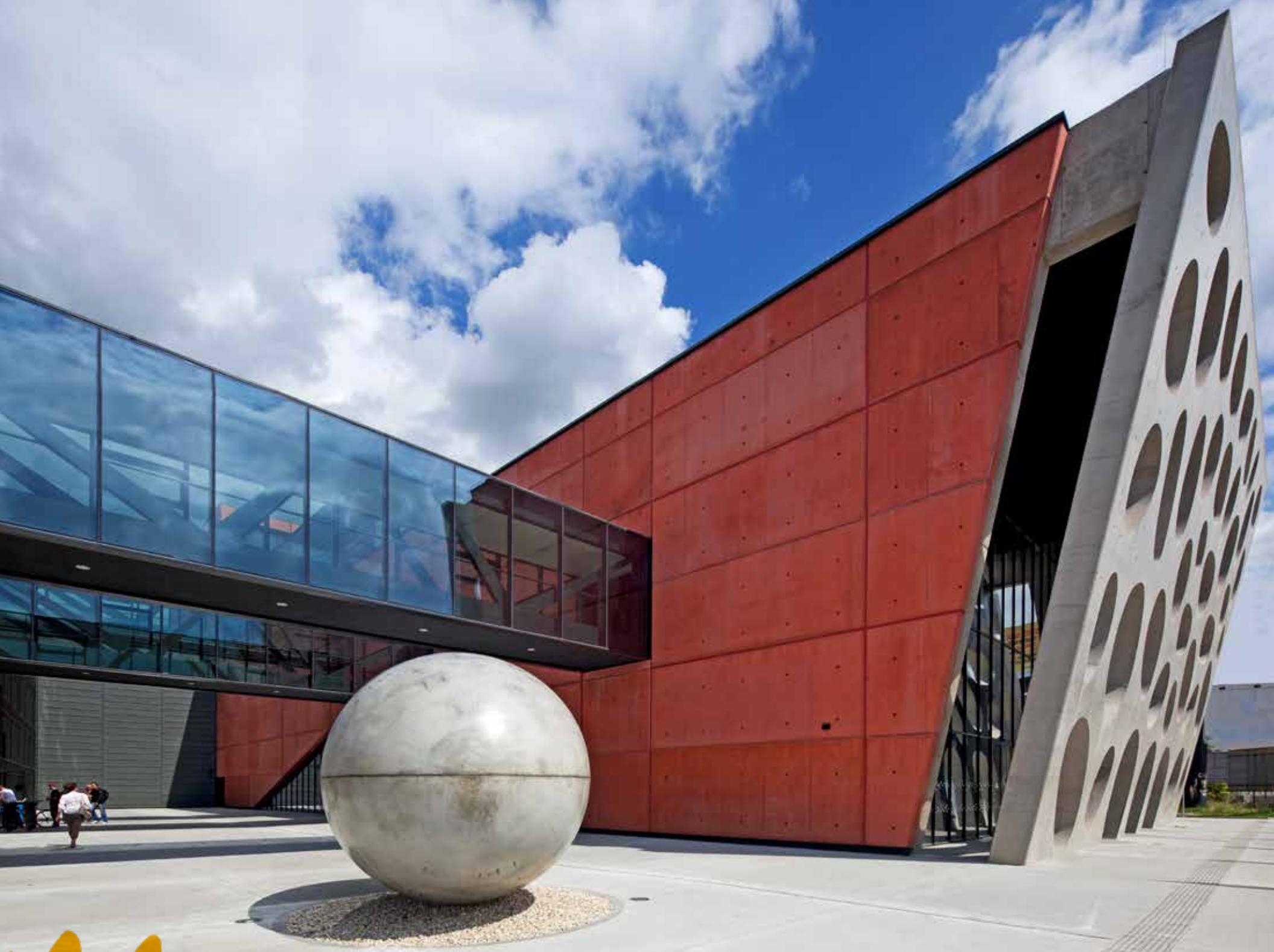
Structura de suport: structura de suport: perete de tip sandwich si placă de beton monolit, conectată cu structura de rezistență prin ancore de oțel de înaltă rezistență, care pot fi nivелate.
