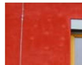
Ak je tanier štandardnej kotvy umiestnený tesne pod vonkajším povrchom, pri spoločnom pôsobení vonkajších vplyvov môže dôjsť k vykreslovaniu obrysov taniera na povrchu fasády.
