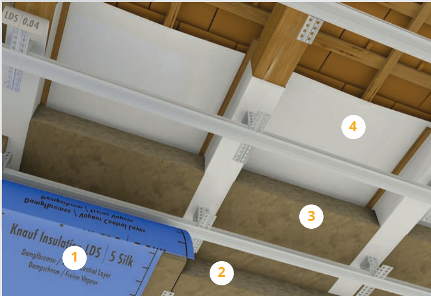
Slika 3: kosi krov - sanacija s unutarnje strane
