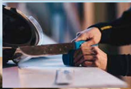
Kvarteret Dörren har isolering fra Knauf Insulation i inner- og yttervegger og på loftene. Og den unike kniven lærer men seg raskt å håndtere, mener Patrik Wiklund, prosjektleder i GBJ Bygg.
